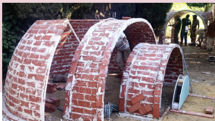
Proceso de construcción de bóvedas. Fotografía: Manuel Gil
