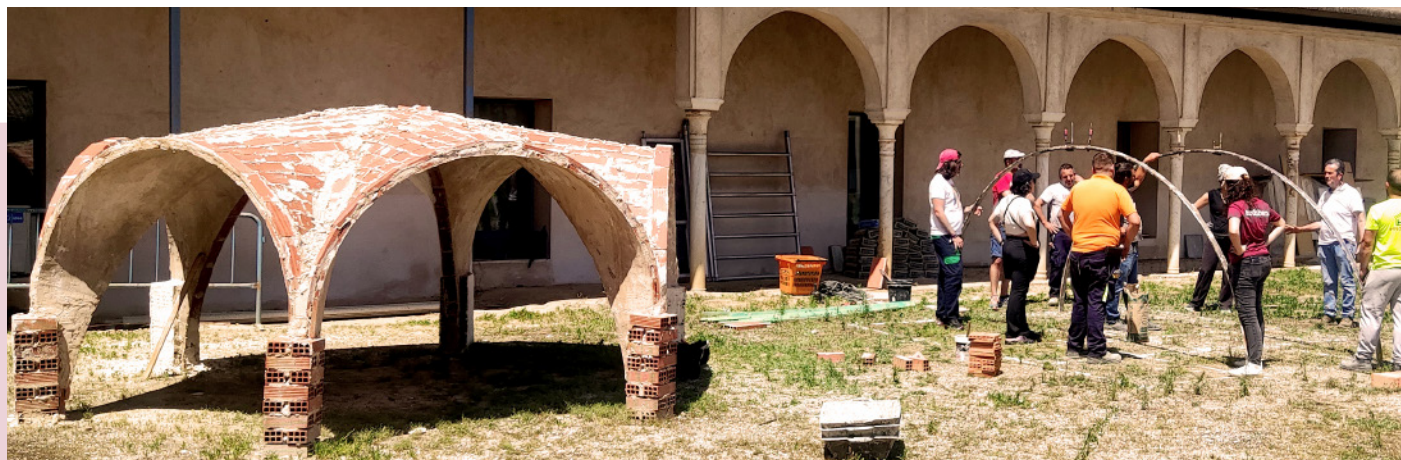
Proceso de construcción de bóvedas. Fotografía: Manuel Gil
