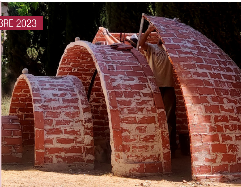
Bóvedas. Fotografía: Manuel Gil
